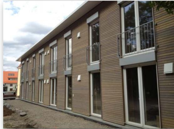
Es handelt sich um Neubauten, der besonderen Art. Es sind Effizienzhäuser 40 ökologisch solar gebaut aus komplett nachwachsendem Baustoff Holz. Sie sind dampfdiffusionsoffen, haben Wände aus Fichtenholz der Fußboden besteht aus geseiften Eichendielen.
